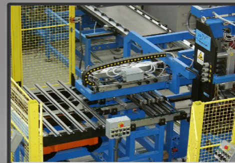
Dettaglio caricatore rinforzi
